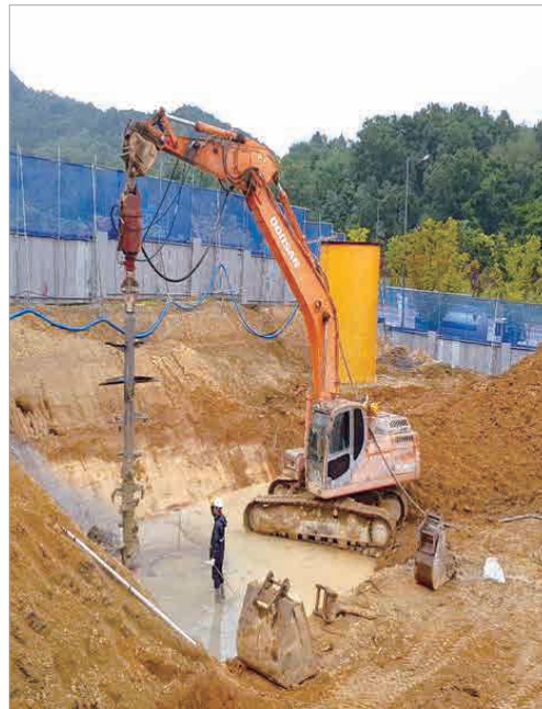
파일형 수평개량 (Horizontal Mixing Pile)
